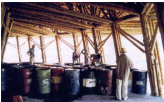
23) "Bild 19. Emporen-Testmasse aus Wasserfässern"
